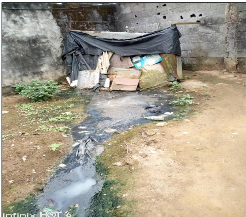
**Photo 5:** Eaux grises stagnantes derrière une douche construite avec des matériaux de récupérations au quartier Clouetcha
